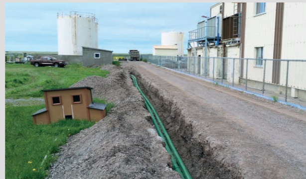
Depo Tesisi, Fransa
