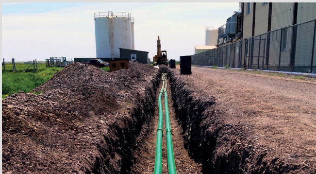
Tanques de almacenamiento de combustible, Francia
