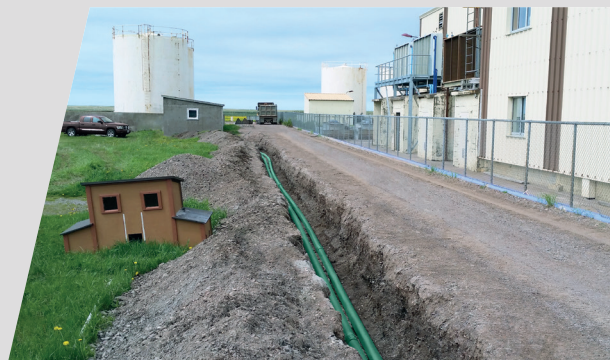
Tanques de almacenamiento de combustible, Francia
