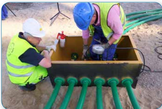
Christian Niejahr da OPW Sweden ajuda um instalador na obra.
