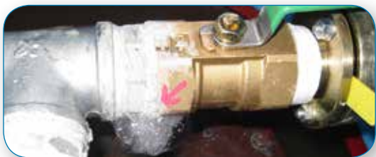
A formação de bolhas é uma indicação segura que há uma fuga.
