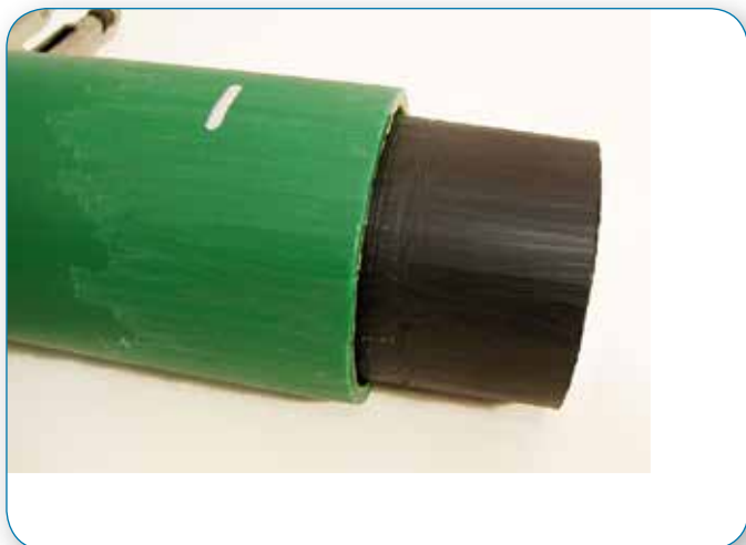
Korrekt skrapade rör. Oxidlagret är borta från hela området som ska svetsas.
