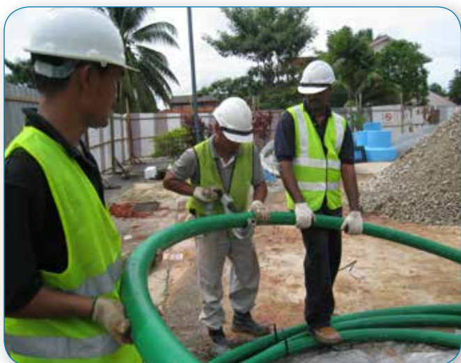
En person bör hjälpa till att hålla röret medan det kapas.
