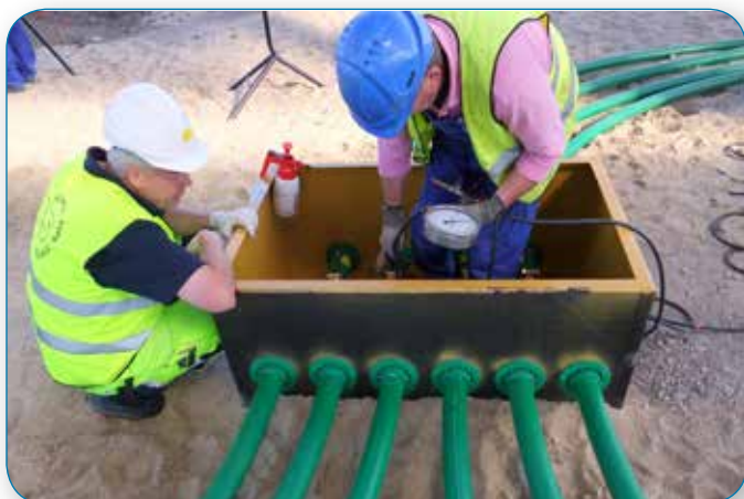
Christian Niejahr från OPW Sweden assisterar en installatör på plats.
