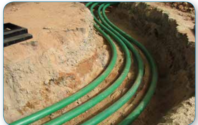
Rullade rör lagda i mjuka böjar gör det möjligt för rören att ta upp rörelser orsakade av temperaturförändringar eller sättningar i marken.
