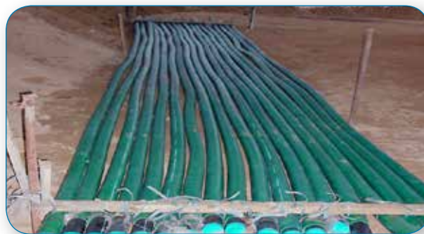
Uträtning av rör som varit på rulle.
