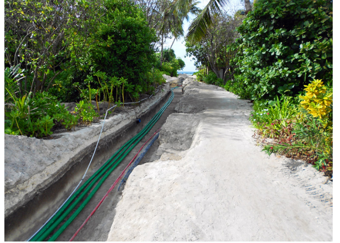
Yakıt ikmal iskelesinden gömmeye hazır depolama tanklarına kadar kurulu borular
