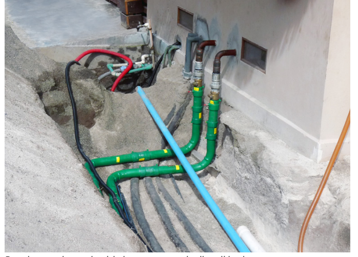
Depolama noktasından iskeleye uzanan yakıt ikmal hatları
