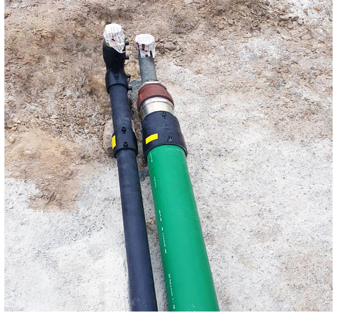
KPS çift cidarlı boruları, iç ve dış borular arasındaki ara boşluk üzerinde kontrol sağlar, bu da bir sızıntının hızlı bir şekilde bulunup kontrol altına alınabileceği anlamına gelir
